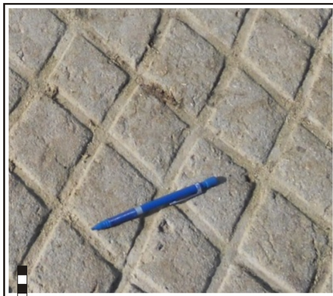
En las cruzadas se pueden combinar diferentes diseños (cuadrada, romboidal) y materiales (hormigón, sintéticos), según el sector.
