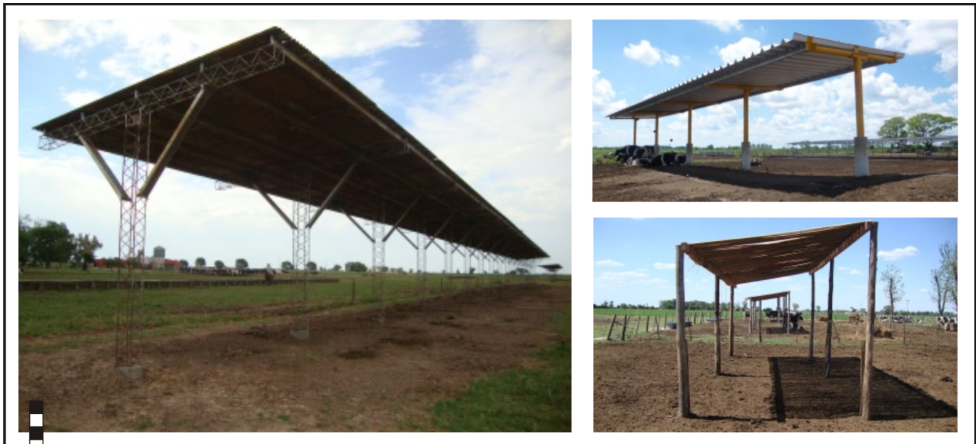
Sombras construidas con madera v chapa.
