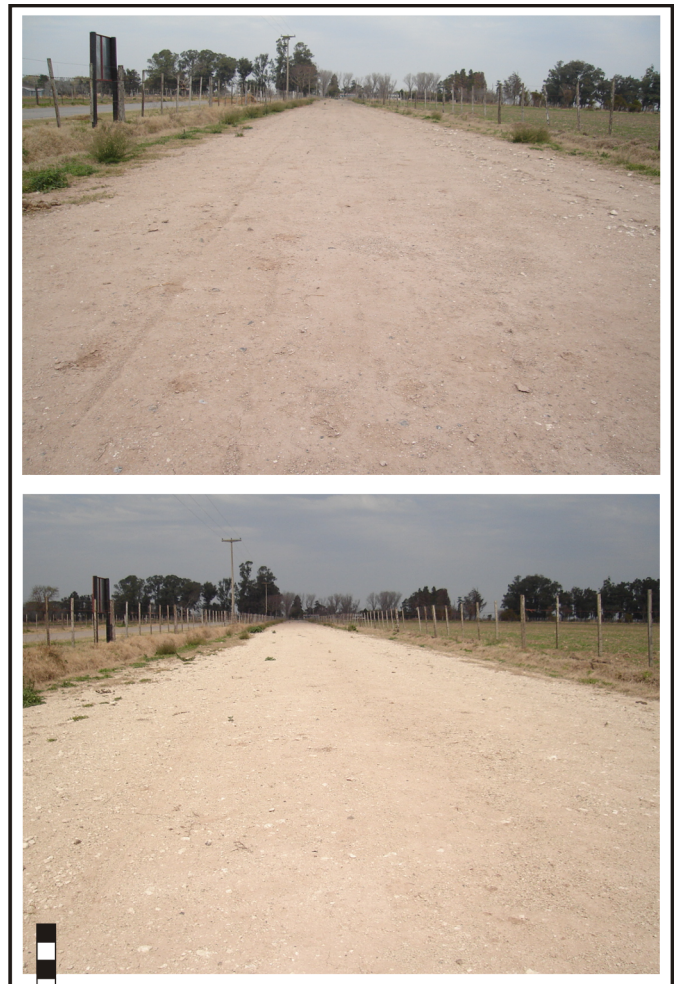
Callejones afirmados con suelo cal (arriba) y broza calcárea (abajo).
