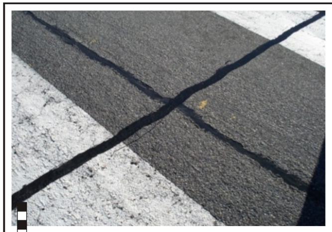
La medida de los paños condiciona la vida útil del piso.
