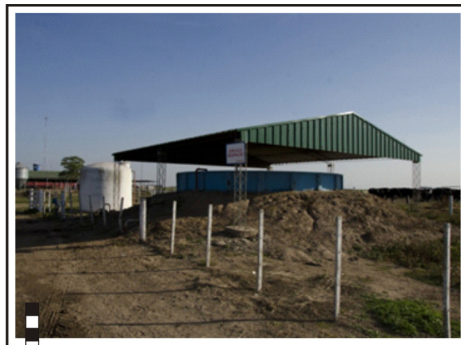
Depósito de agua cubierto.
